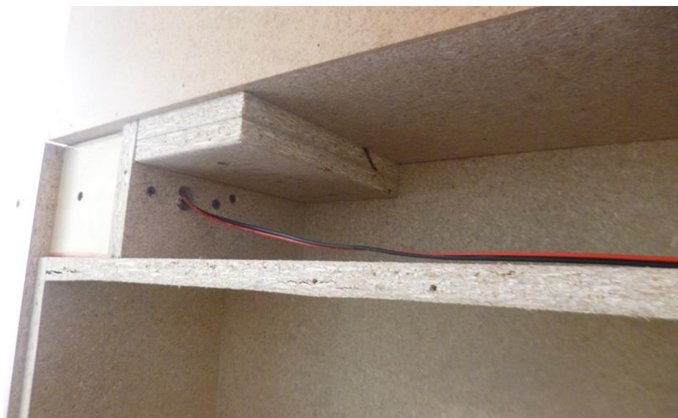
Фото № 9. Фрагмент конструктива изделия с тыльной стороны.
