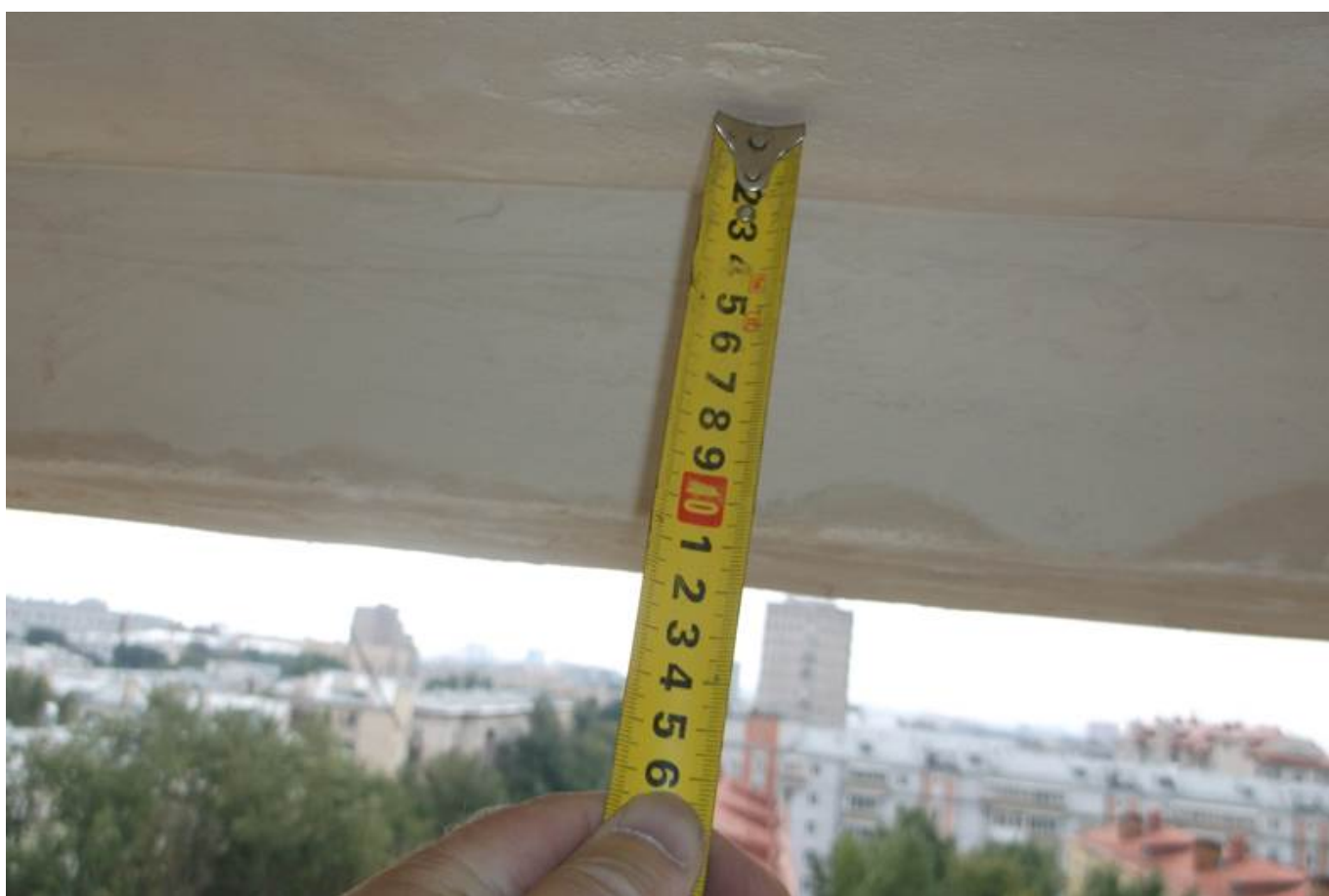
Фото №6. Вид балкона кв. 38.
