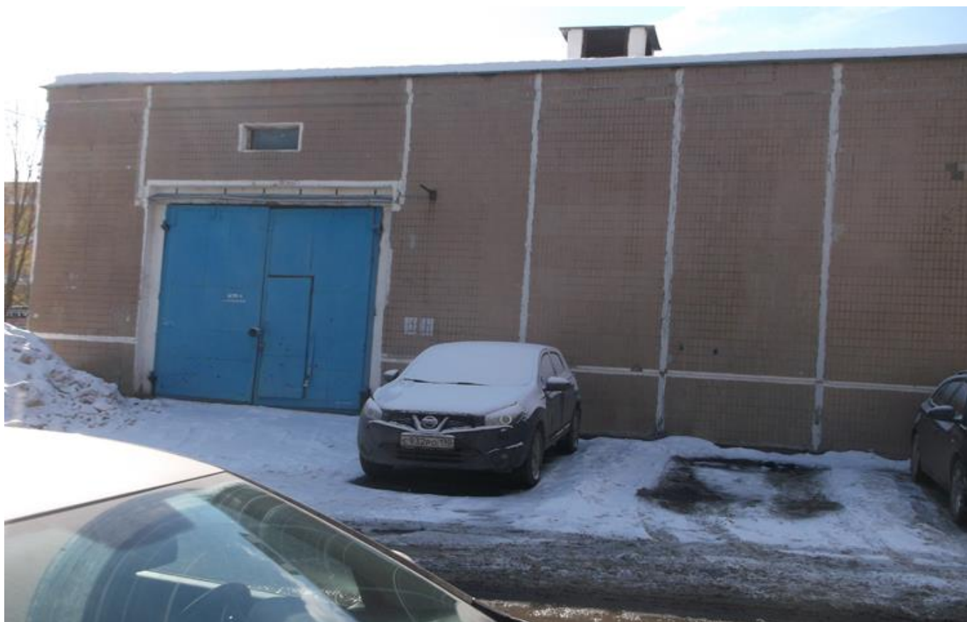
Фото № 1. Фрагмент фасада здания ЦТП-1.
