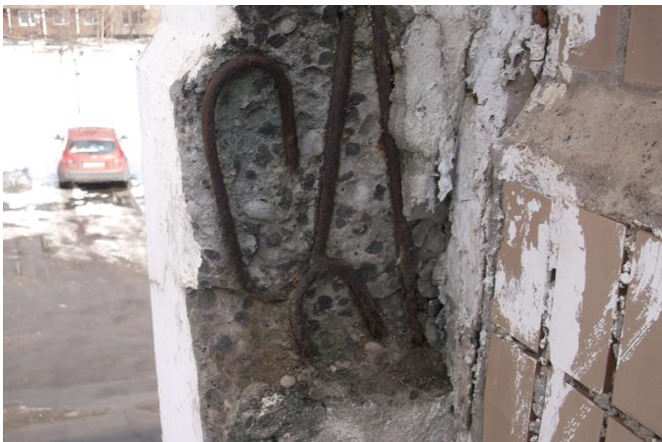
Фото № 2. Фрагмент фасада здания ЦТП-1.
