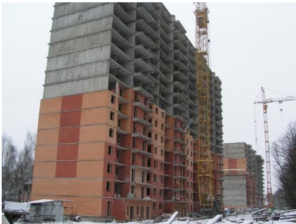
Определение объемов строительства, г.Москва
