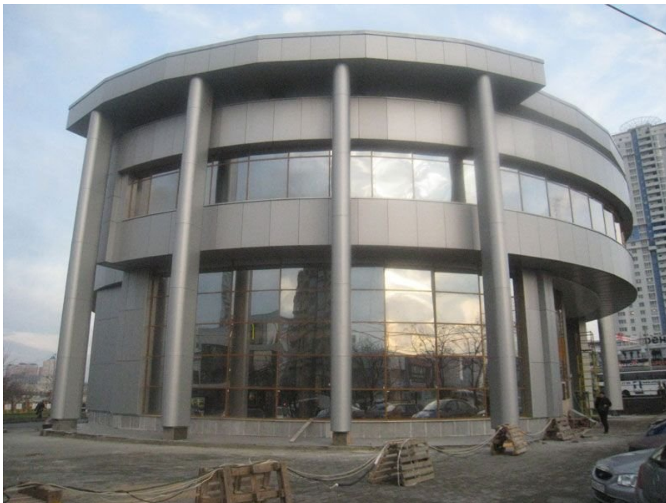
Оценка качества, объема и стоимости выполненных работ по монтажу фасадной системы общественного центра, г.Москва
