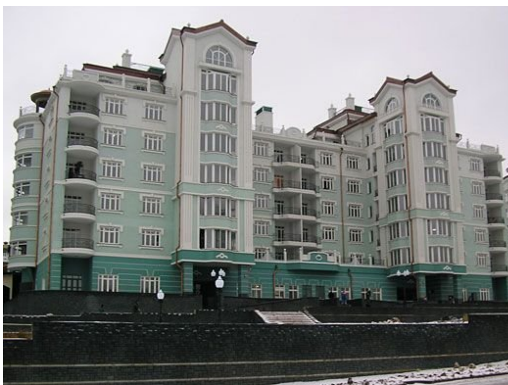
определение объемов фактически выполненных работ в Жилом комплексе Покровский берег г.Москва
