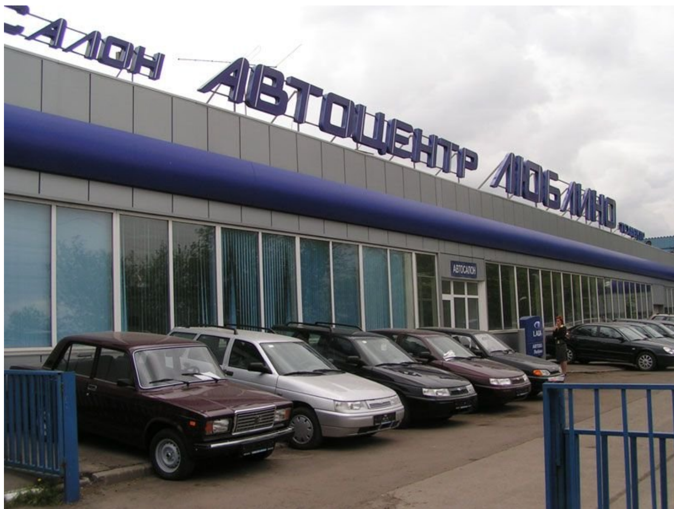
Оценка качества и объемов выполненных работ по реконструкции помещений автосалона АВТОВАЗ-Люблино г.Москва
