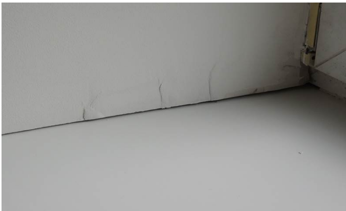
Фото № 13. Подвальное помещение.
