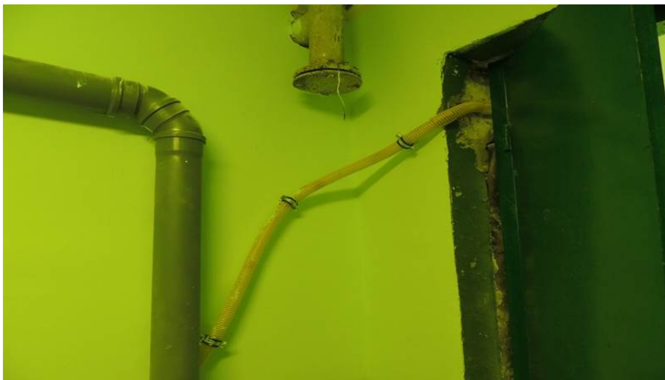
Фото № 10. Подвальное помещение.
