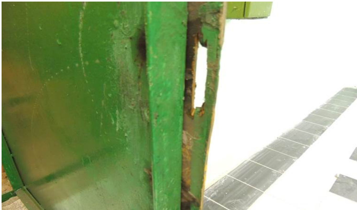
Фото № 7. Подвальное помещение.
