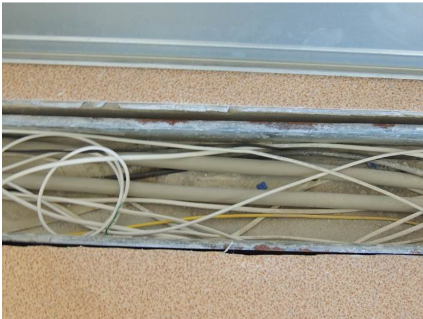
Фото.12 Прокладка проводов и кабелей в канале.
