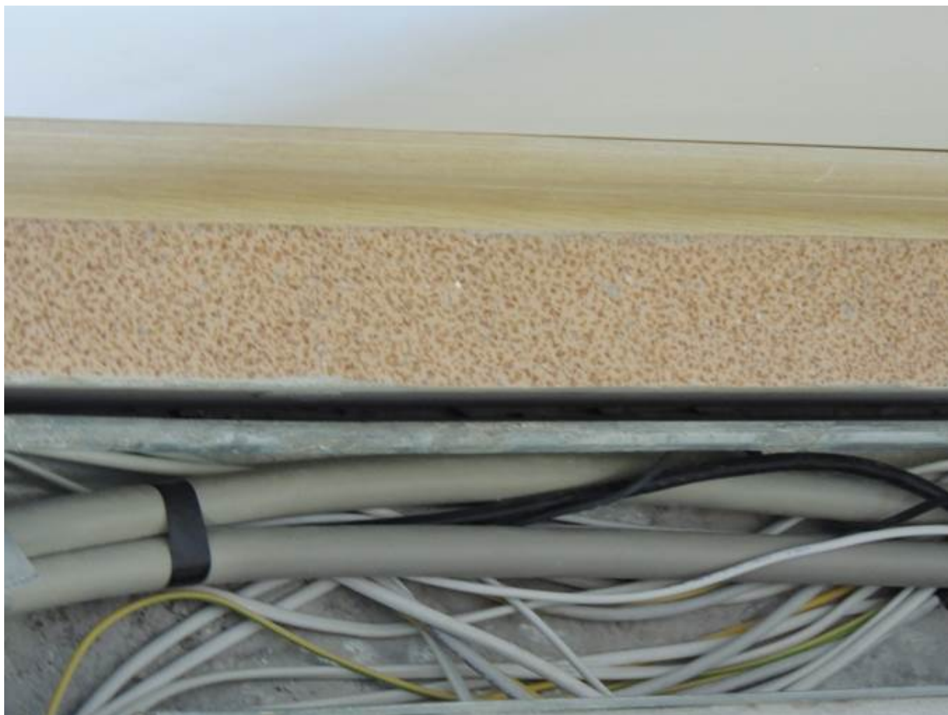
Фото.10 Установка кабельного подпольного канала.
