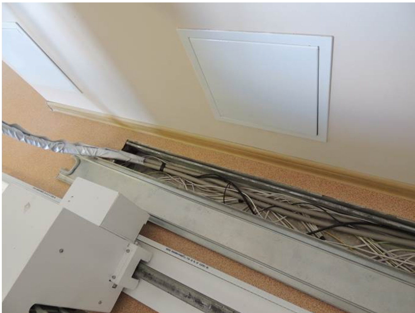
Фото. 14Кабель-канал внутри не покрашен, имеются заусенцы, строительный мусор, острые кромки и прочее.
