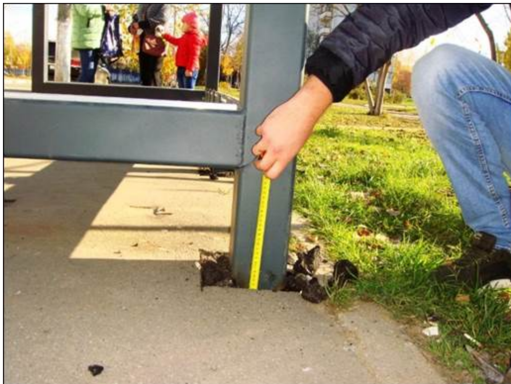
Фото 3,4 Измерение толщины слоя асфальта
